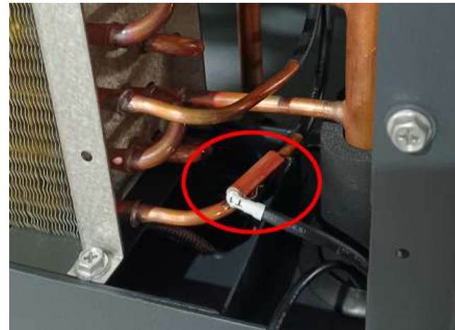
Temperatursensor an der Heizspule des Verdampfers (5K)
